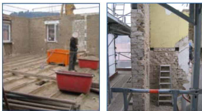
Rückbau der Außenwände im Obergeschoss, Baustelle im Dezember 2016 (Quelle: Tragwerksplaner).
