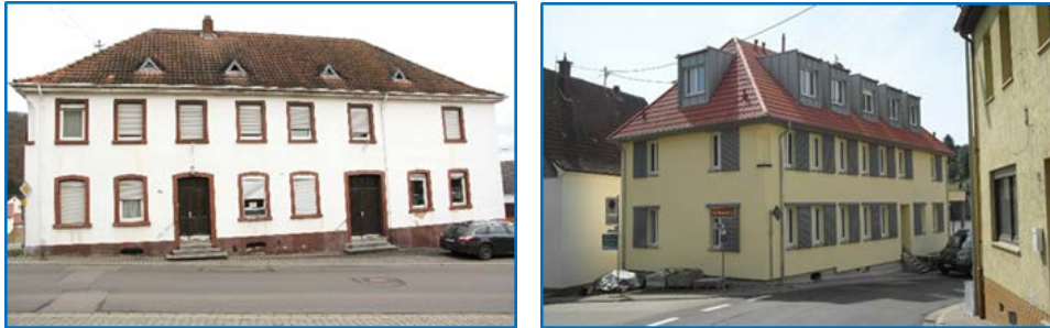
Ansicht vor dem Umbau im Jahr 2014 (Quelle: Planer) und Ansicht nach dem Umbau im Jahr 2019.
