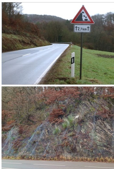
Die Fotos links zeigen das Gefahrzeichen „Steinschlag“ und eine großflächige Felsvernetzung an der L 50 im Planungsbereich. Schon dies dokumentiert, dass durch das Hanggelände im Planungsbereich eine überdurchschnittliche Gefährdungslage für den Verkehr und ein entsprechender Maßnahmenbedarf zu dessen Sicherung besteht. Das Foto rechts zeigt das vom Rechnungshof darüber hinaus aufgefundene Rutschereignis unmittelbar am geplanten Radweg. Quelle: Rechnungshof Rheinland-Pfalz.
