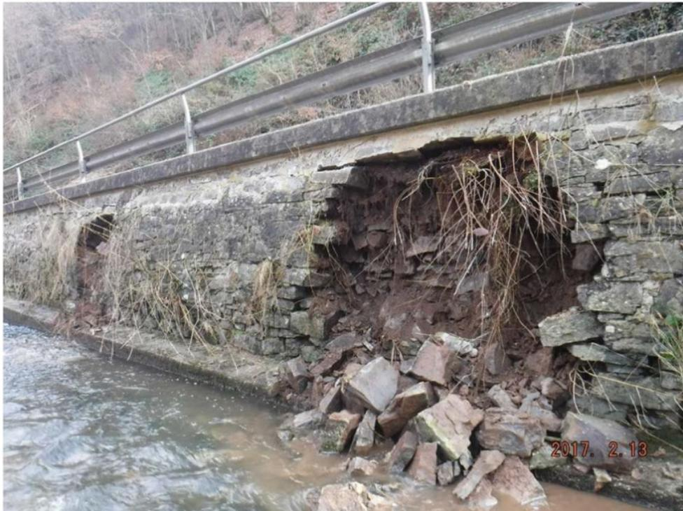
*Teileinstürze eines Stützbauwerks unmittelbar am Fahrbahnrand der Landesstraße 4 infolge einer über zehn Jahre nachlässigen Unterhaltungstätigkeit und nicht ordnungsgemäßer Bauwerkskontrollen.*
