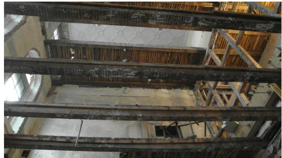
Teilw. entkerntes Gebäudes 2017; Blick vom EG auf die abgehängte Decke über dem 2. OG und auf die nicht tragfähigen Holzbalken der Geschosdecken sowie die Holzkonstruktion der Fachwerkwände.
