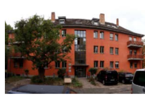
Gebäude C - 525 €/m 2
