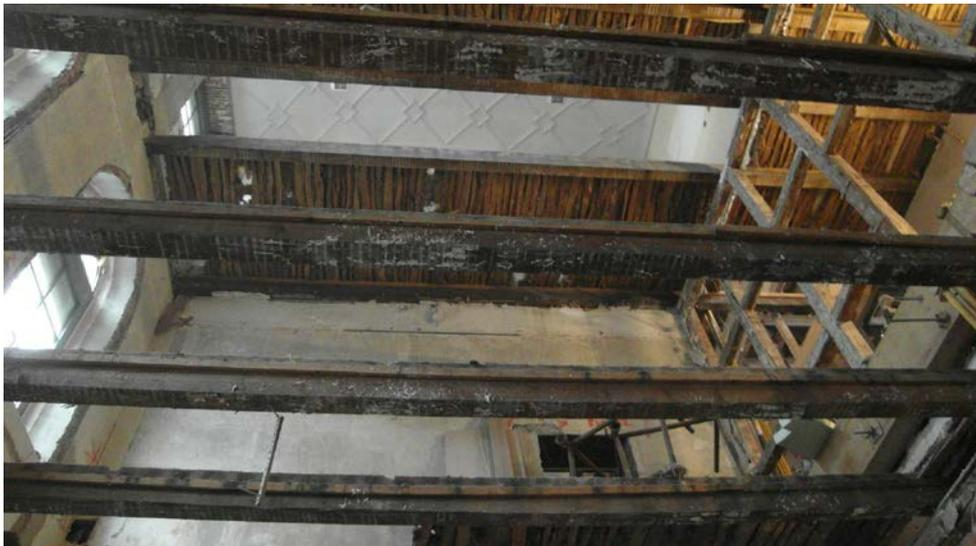
Zustand des teilweise entkernten Gebäudes im Februar 2017; Blick vom Erdgeschoss auf die abgehängte Decke über dem zweiten Obergeschoss und auf die nicht tragfähigen Holzbalken der Geschossdecken sowie die Holzkonstruktion der Fachwerkwände.
