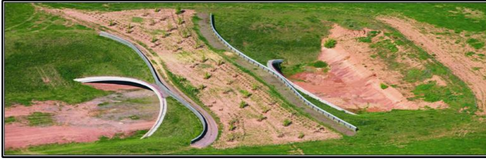
Das Bild zeigt eine „standardmäßige“ Grünbrücke als Querungsbauwerk für Tiere.
