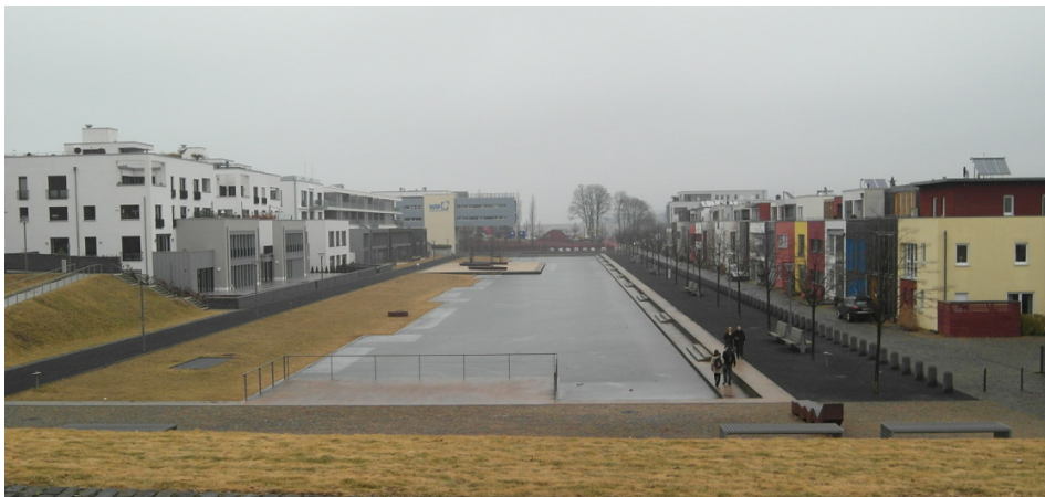
Sogenanntes Wasserband auf dem Gelände der ehemaligen Landesgartenschau Trier.
