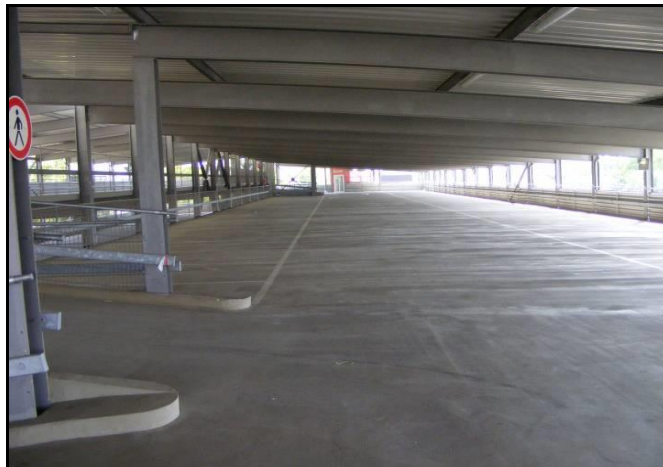
Die Fotografie zeigt eine leere Parkebene im P+R-Parkhaus Frankenthal.
