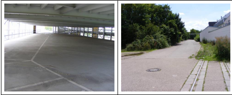
Die Fotografien zeigen eine leere Parkebene im P+R-Parkhaus Speyer und leerstehende Parkflächen in unmittelbarer Bahnhofsnähe, die ein Jahr nach Eröffnung des Parkhauses abgesperrt wurden.
