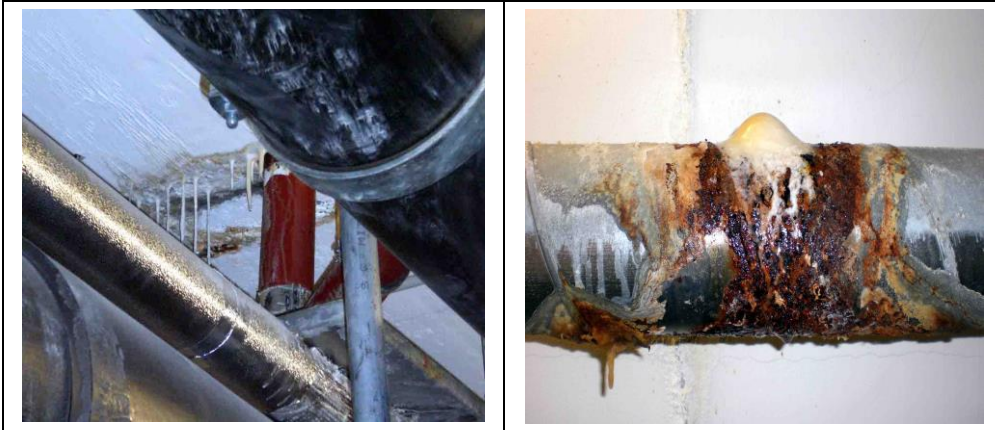
Undichter Bodeneinlauf mit Stalaktitenbildung
