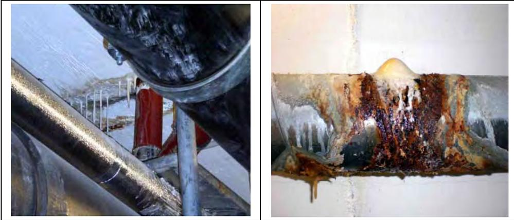
*Undichter Bodeneinlauf mit Stalaktitenbildung*
