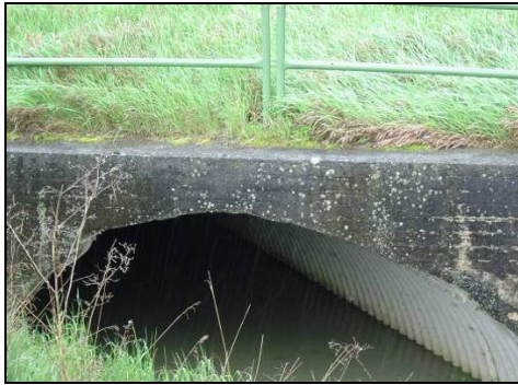
Brücke bei Dannstadt-Schauernheim (L 530)
