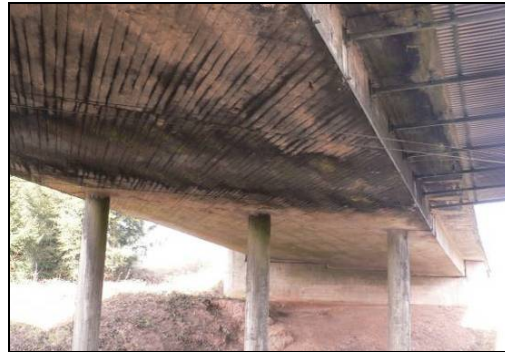
Brücke über DB-Strecke bei Salmtal (L 141)
