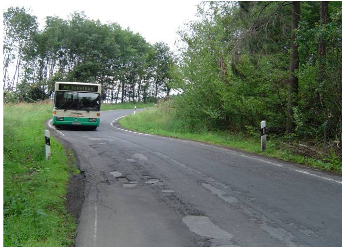
Bauzustand der L 289
