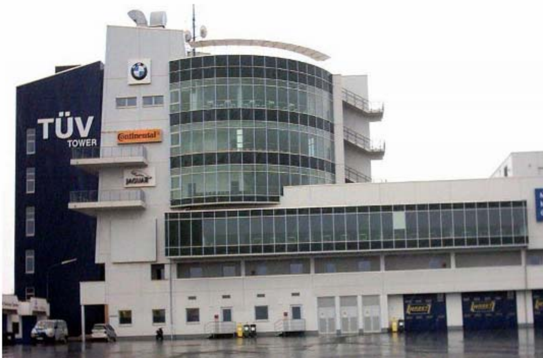
Teilansicht neues Boxengebäude
