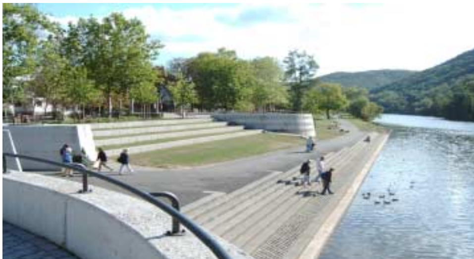
Bereich zwischen Schutzmauer und Nahe
