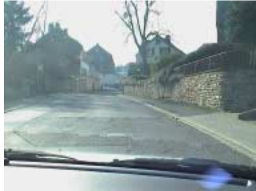
K 21 Ortsdurchfahrt Hottenbach
