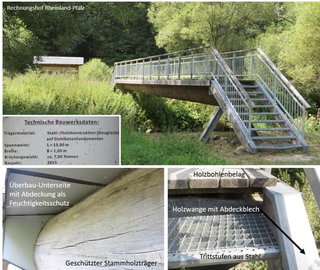
Abbildung 42: Fußgängerbrücke Hahnenbach als Stahl-/Holzkonstruktion
