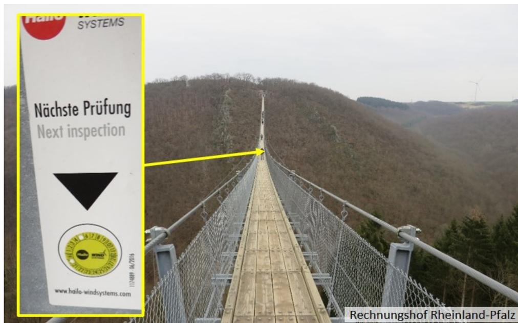
**Abbildung 17:** Prüfplakette mit Hinweis auf die nächste Brückenprüfung
