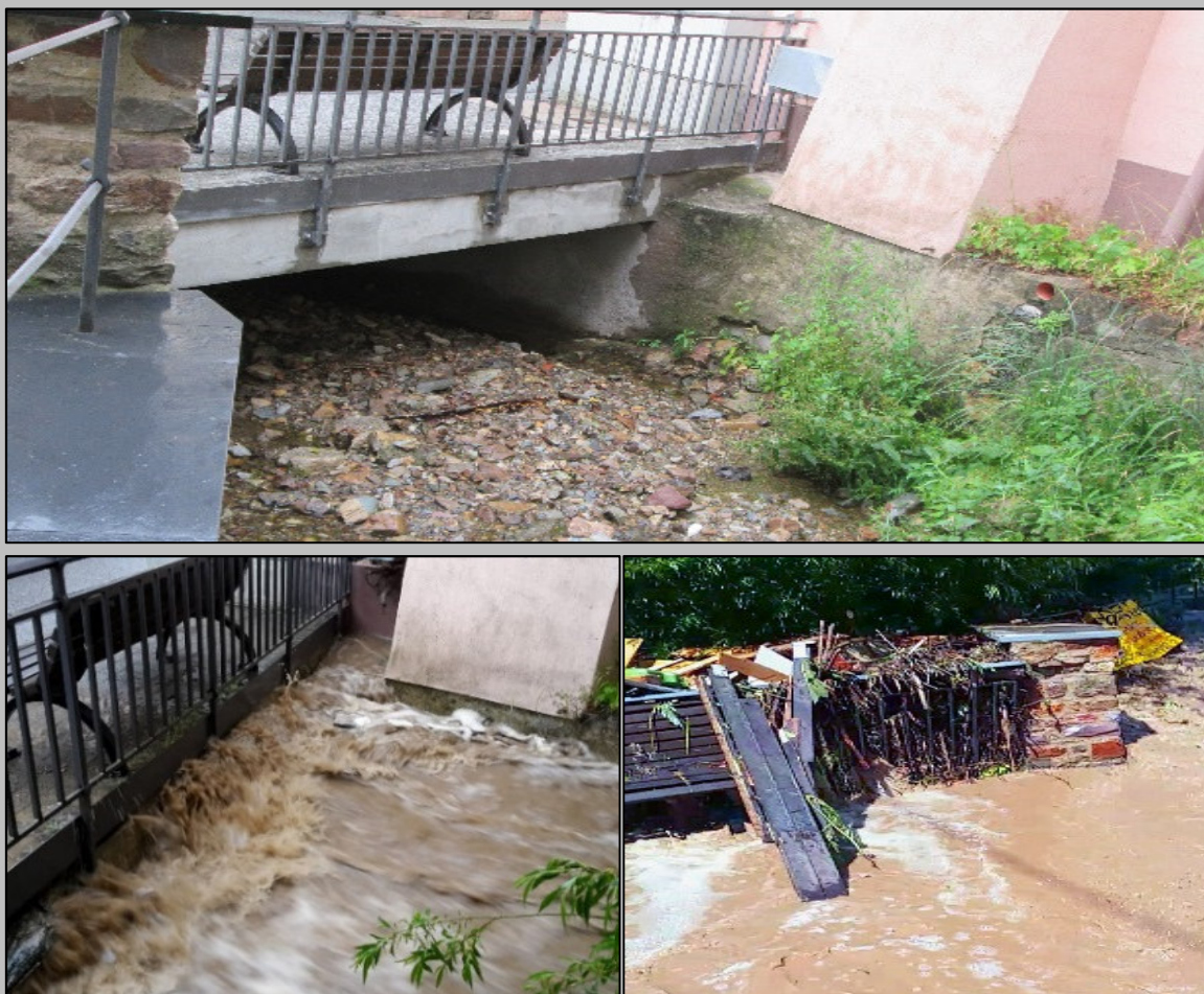
Abb. 25 Überschwemmung im Juni 2016 in Stromberg; Das obere Foto zeigt die Gewässersituation mit Durchlass vor dem Starkregenereignis; Die Fotos unten zeigen die Situation während (links) und nach (rechts) dem Starkregenereignis; Quelle: Gemeinde.
