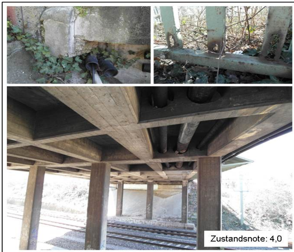
Abbildung 28: Straßenbrücke "Obere Langgasse", Speyer
