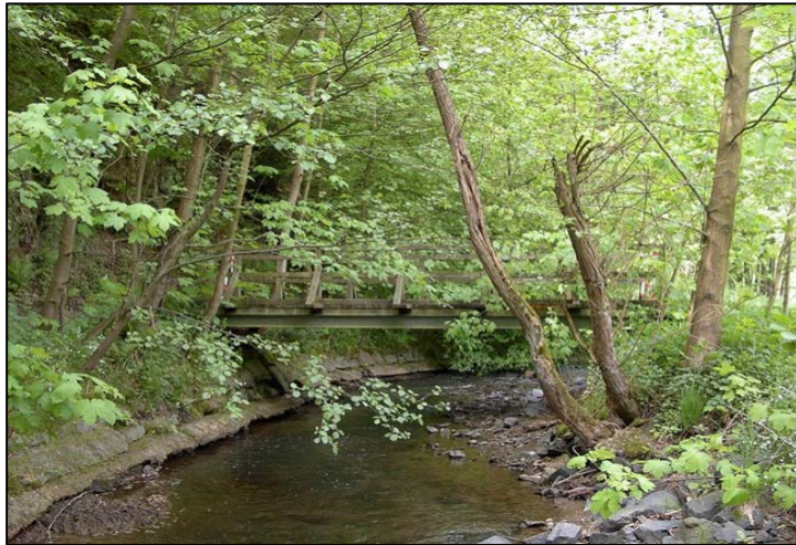
Abbildung 36: Ungeeigneter Standort für eine Holzbrücke
